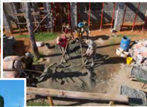
Préparation du béton. Il n'y a pas de bétonnière sur le chantier.
